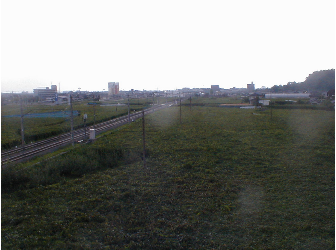
甲府市街地最東端 中央本線酒折～石和温泉 横根跨線橋から甲府方向をみる
